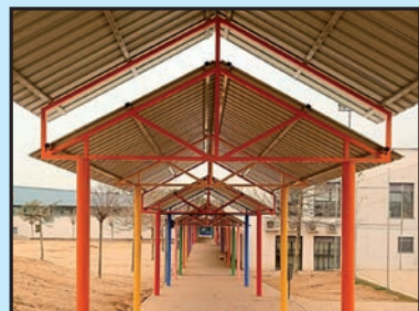
ESTRUCTURAS METÁLICAS CON CHAPA TRAPEZOIDAL
